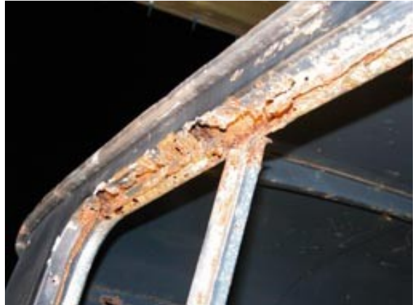
nach der Demontage: Gruseln!
